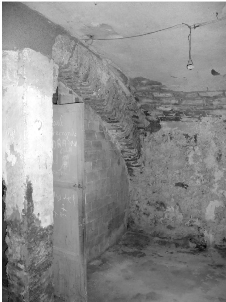
Uno de los arcos de medio punto construido en ladrillo a rosca sobre el que apoyan las bóvedas tabicadas.
