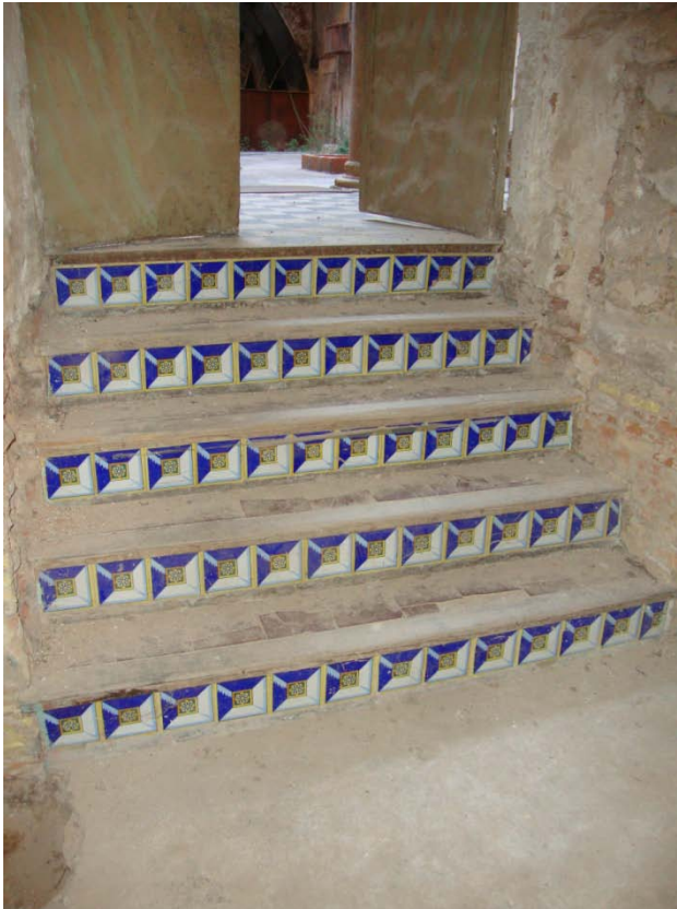
Escalones que "dan acceso" desde el claustro a la sala de la bóveda
