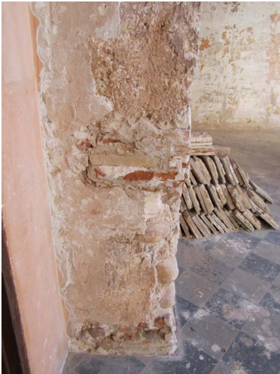
Cata muraria abierta en el paramento este del primer piso del claustro.
