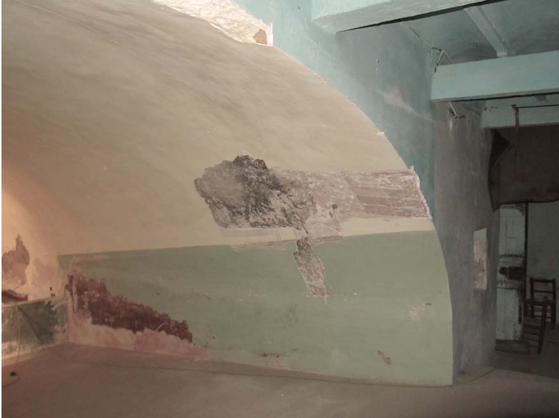
Cata muraria abierta en el extremo norte de la bóveda de cañón del antiguo cine.
