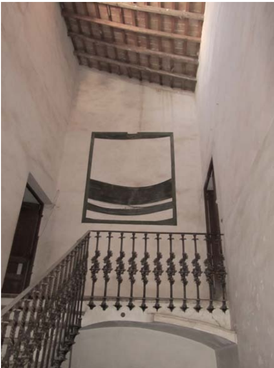
Desembarco de la escalera de mármol de dos tramos en la segunda planta.
