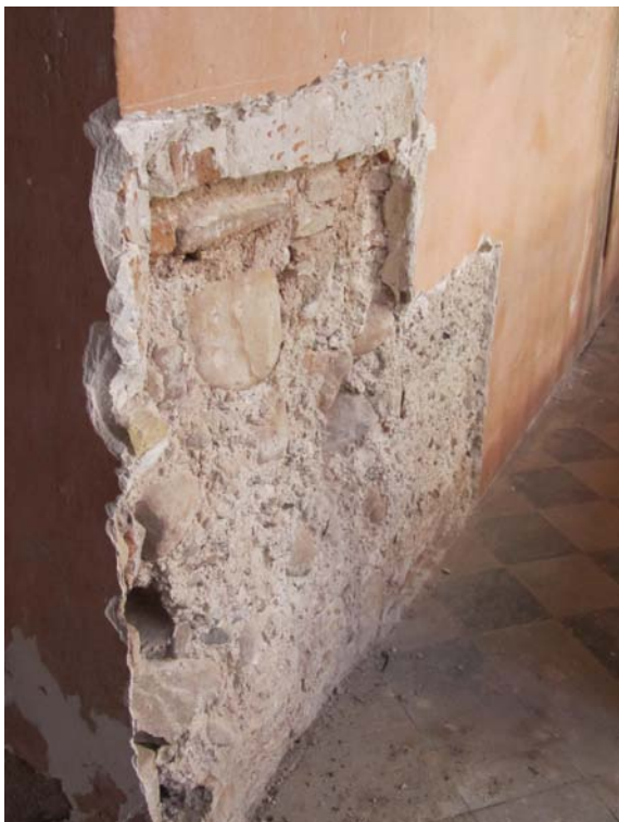
Cata muraria abierta en el paramento sur del primer piso del claustro. Corresponde con la cata muraria 5 de las actuaciones arqueológicas llevadas a cabo en el monumento en 2008.
