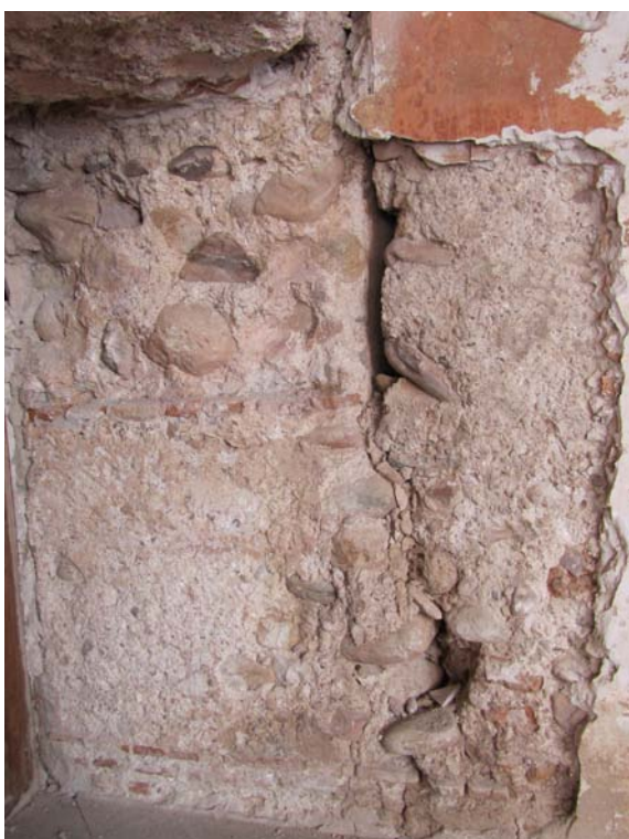
Cata muraria abierta en el paramento sur del primer piso del claustro.
