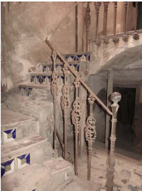
Escalera tabicada de cuatro tramos y muy degradada, situada en lo que fue la panda este del claustro.
