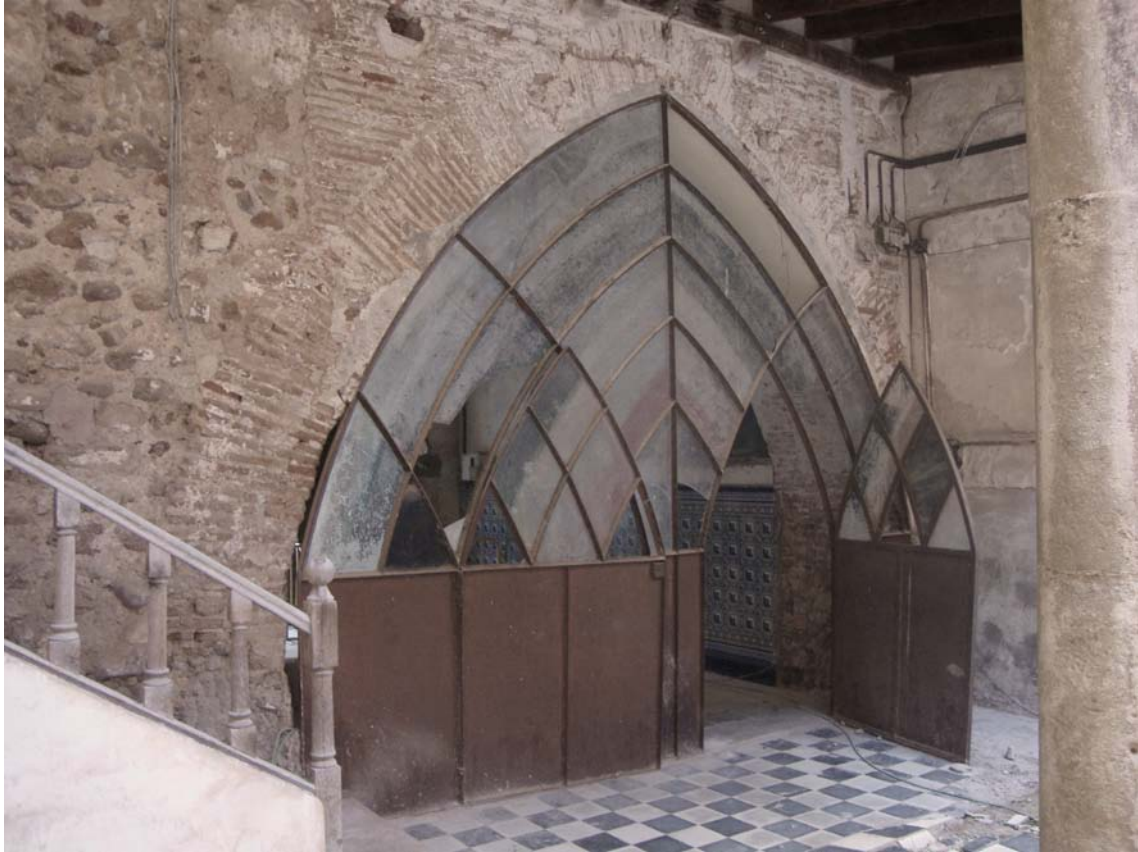
Arco apuntado de ladrillo a rosca que da paso desde el zaguan hasta el claustro.
