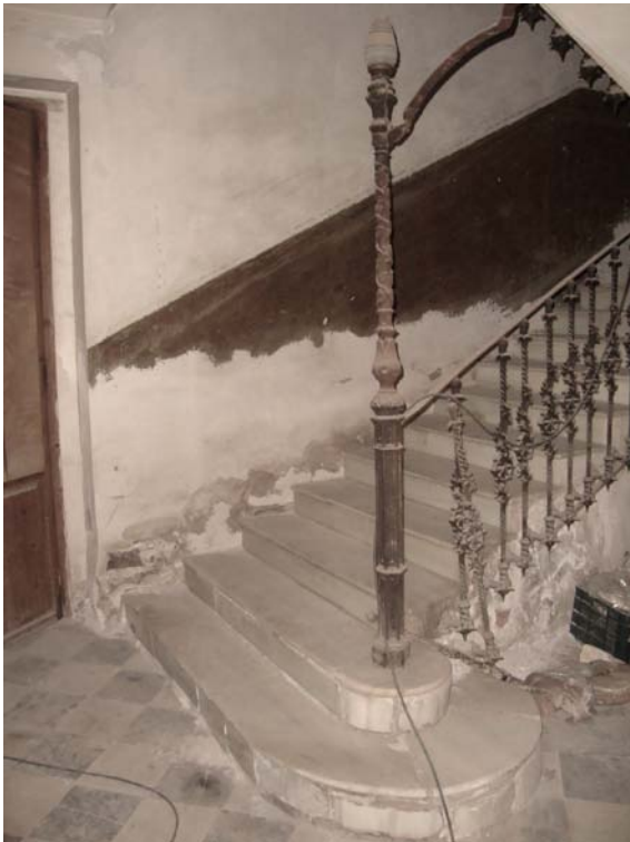
Arranque de la escalera de mármol de dos tramos situada en la casa de Pascual Meneu.
