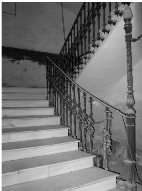
Escalera de principios del siglo XX. Planta baja de la Casa de Pascual Meneu.
