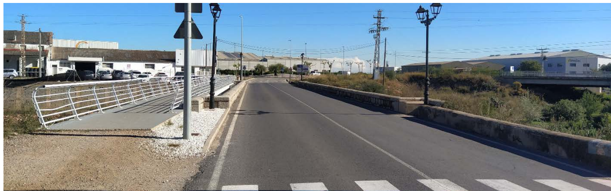
Ilustración 64. Avenida Joaquim Dualde. Tramo I junto a Río Seco. Fuente: Imagen tomada durante visita de campo
