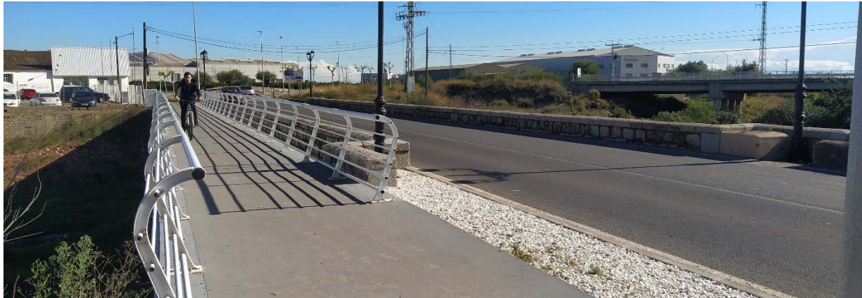
Ilustración 84. Pasarela ciclopeatonal sobre Río Seco. Fuente: Imagen tomada en visita de campo
