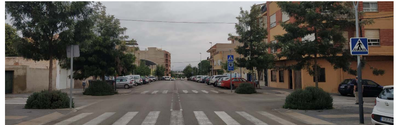
Ilustración 65. Avenida Joaquim Dualde. Tramo II. Fuente: Imagen tomada durante visita de campo
