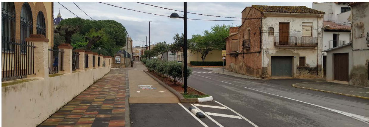
Ilustración 89. Carril bici en la calle Onda. Fuente: Imagen tomada en visita de campo.
