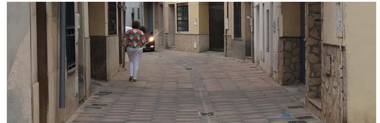
Ilustración 5. Propuesta de plataforma única siguiendo el modelo implementado en otros viales de similares características. Fuente: Imagen tomada durante visita de campo.
