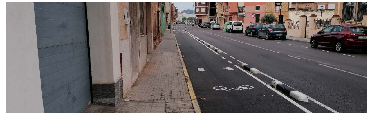
Ilustración 87. Carril bici en tramo I de la Av. Sant Josep Obrer. Fuente: Imagen tomada en visita de campo.
