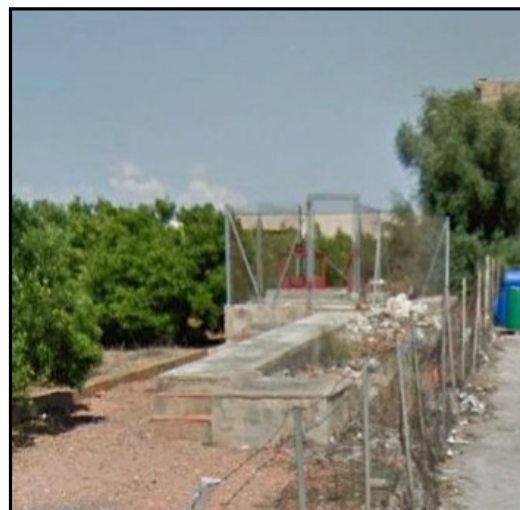
Foto nº4 y 5.- Vista de la obra existente: válvulas compuerta de cambio de sección y de desagüe al río.
